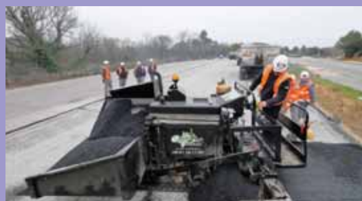
Les travaux d'aménagement de l'aire de covoiturage Les 4 Chemins à Nans-les-Pins
